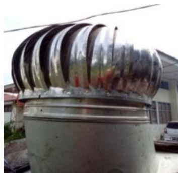
Gambar 7. Turbin Ventilator ukuran 16"
