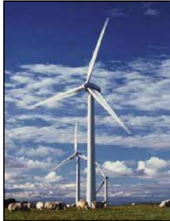
Gambar 2. Turbin Angin Sumbu Horizontal
